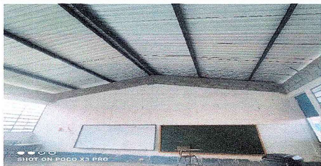
Foto 1: Mantenimiento de estructuras metalicas.
