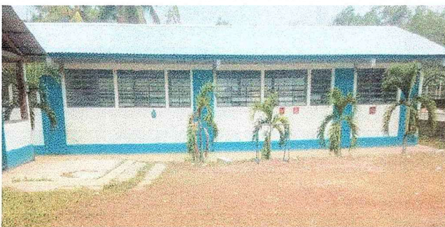
Foto 3: Finalizacion del entechado, se señala el levantamiento de altura con tres hiladas de block.
